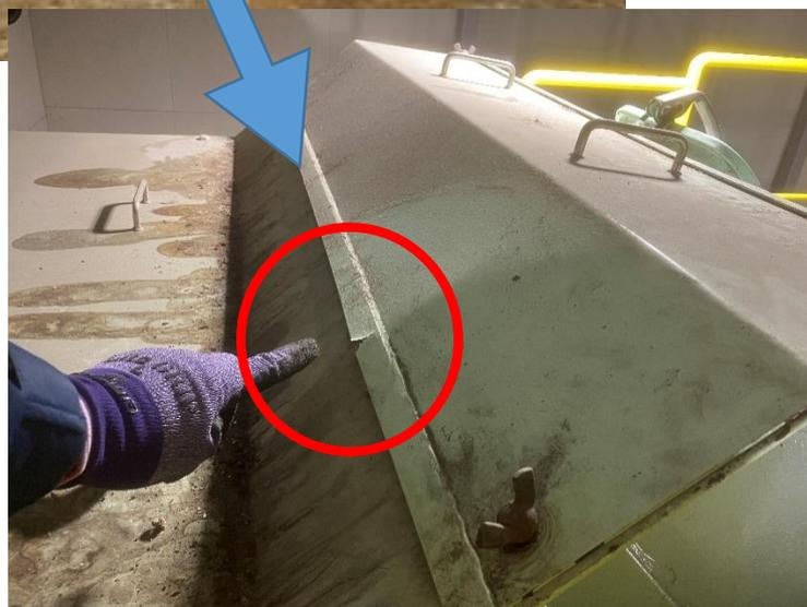
ボルト付き金属棒が焼却灰を運ぶコンベアのケースを突き上げ
